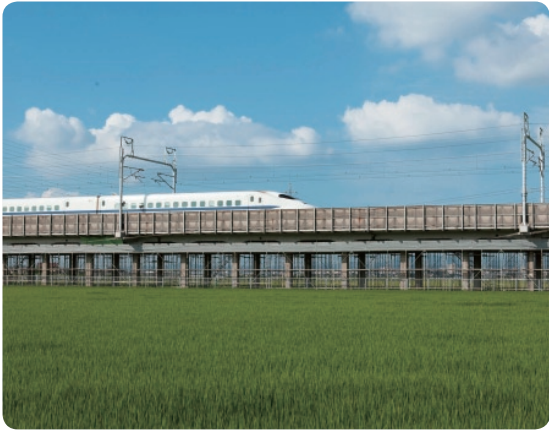
新幹線が駆け抜ける高架橋の下で若返り工事が行われている。
