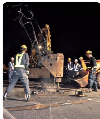
舗装工事の様子
