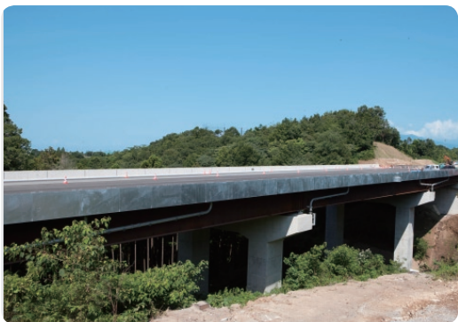
建設中の伊豆縦貫自動車道谷田北高架橋
