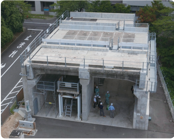
さまざまな劣化・損傷が生じ撤去された橋梁の部材を全国から集めて造られたニュー・ブリッジの全景。
