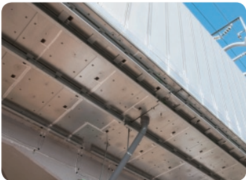
全断面修復工法(鋼板巻き)が施工された高架橋。鋼板自体もメンテナンスフリーの材質を使用。取り付け方法も防音壁と一体となるように改良されたことで支柱レス構造にすることができた。
