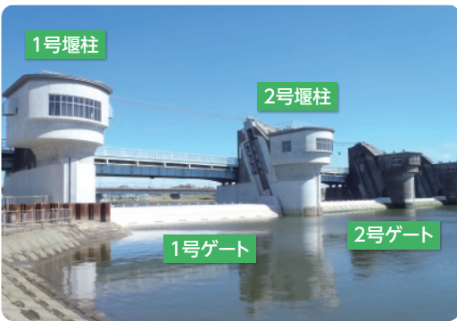
新旧の堰柱が見られる行徳可動堰（平成25年8月現在）。
