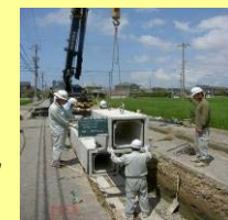
雨水管渠整備
