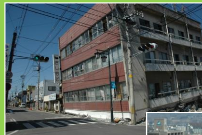
倒壊したビル
