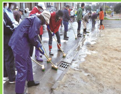
放射線量の低減化を図るため実施されている、通学路の道路除染作業
