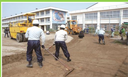
原発事故発生後、他に先駆けて実施した、学校の表土除去
