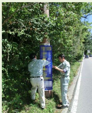
簡易除却実施状況 (立看板)
