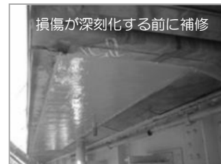
橋梁補修後の状況
