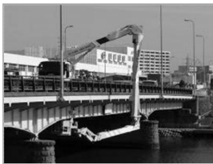
橋梁点検車による点検
