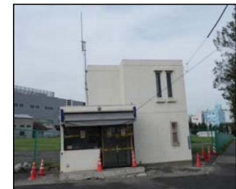
液状化で傾いた建物
