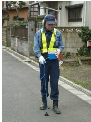
(出典) 川崎の上下水道 2011 写真1-2-1 漏水調査
