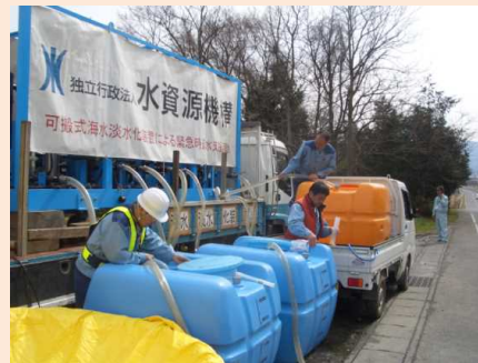
給水タンク給水状況（小野池）
