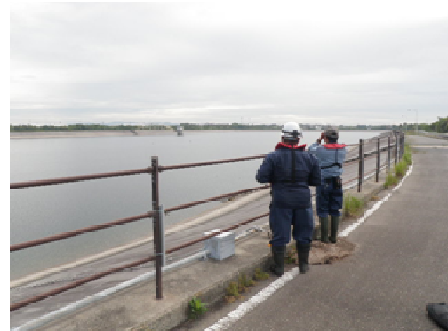
(出典) 独立行政法人水資源機構資料 写真1-2-4 施設の巡視・点検
