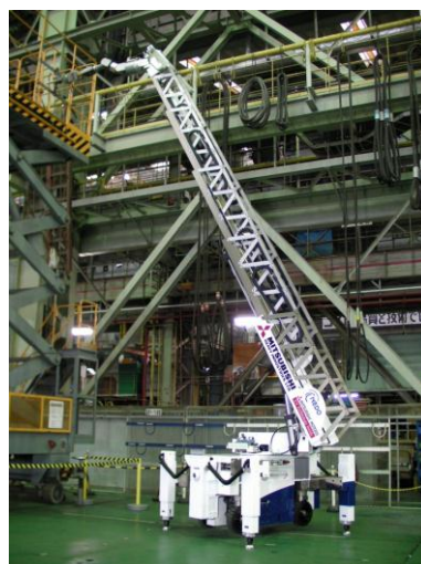
8m高所作業の1例 (バルブ操作)
