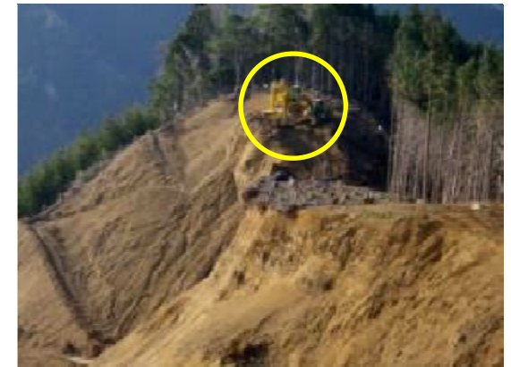
無人化施工の実施箇所状況
