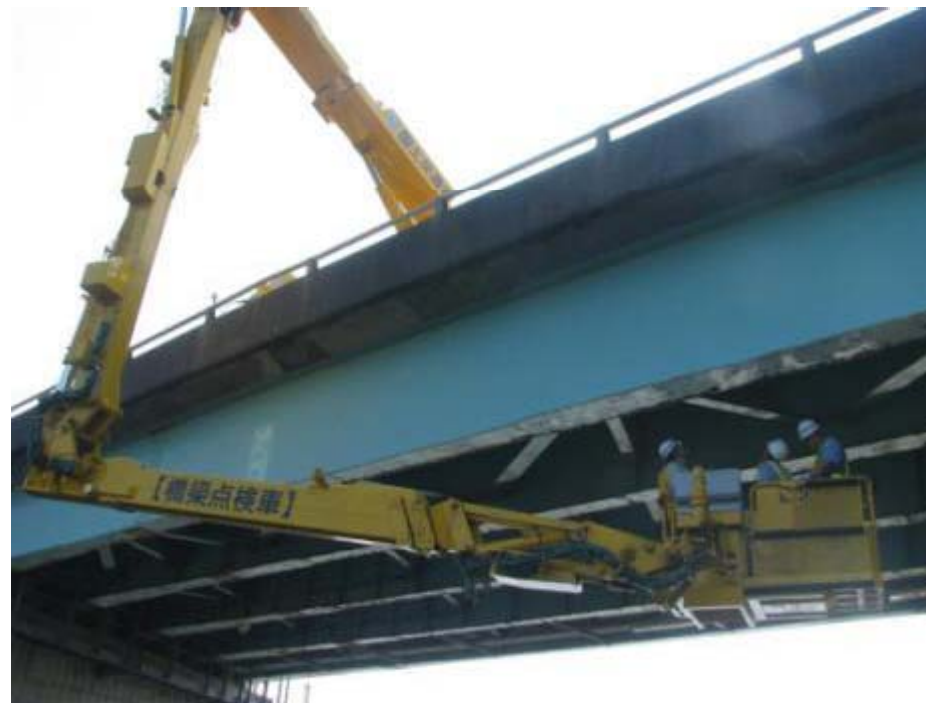
黒川大橋(北陸地方整備局)
