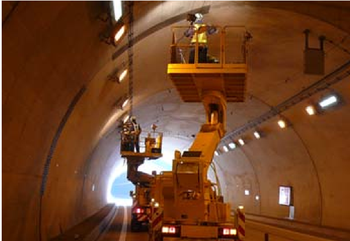
中国横断自動車道 尾道松江線 岩根トンネル
