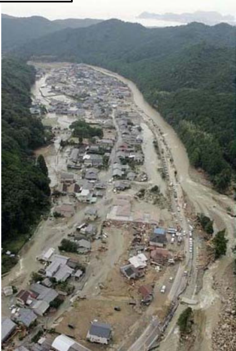
那智川被災状況
