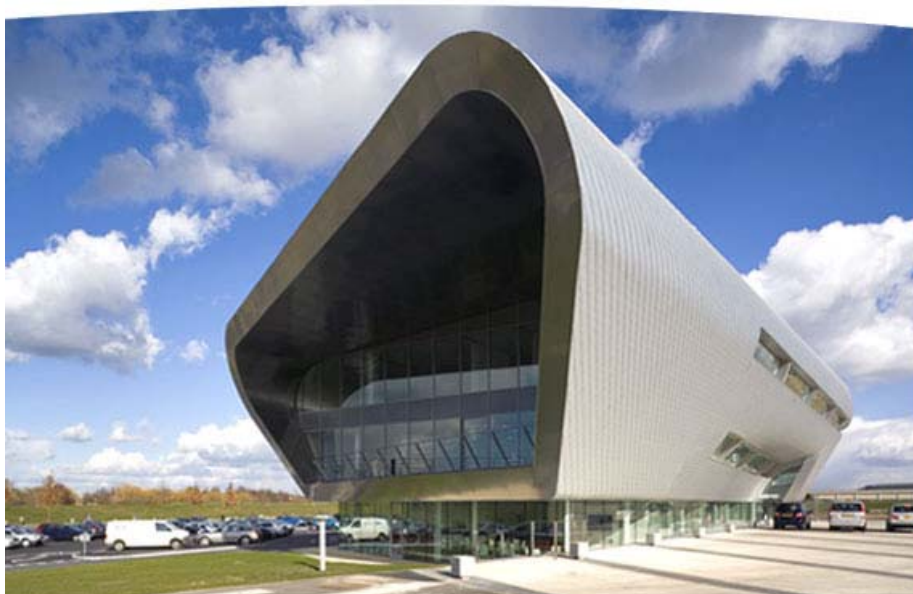
ファンボロー空港ターミナル外観 1
