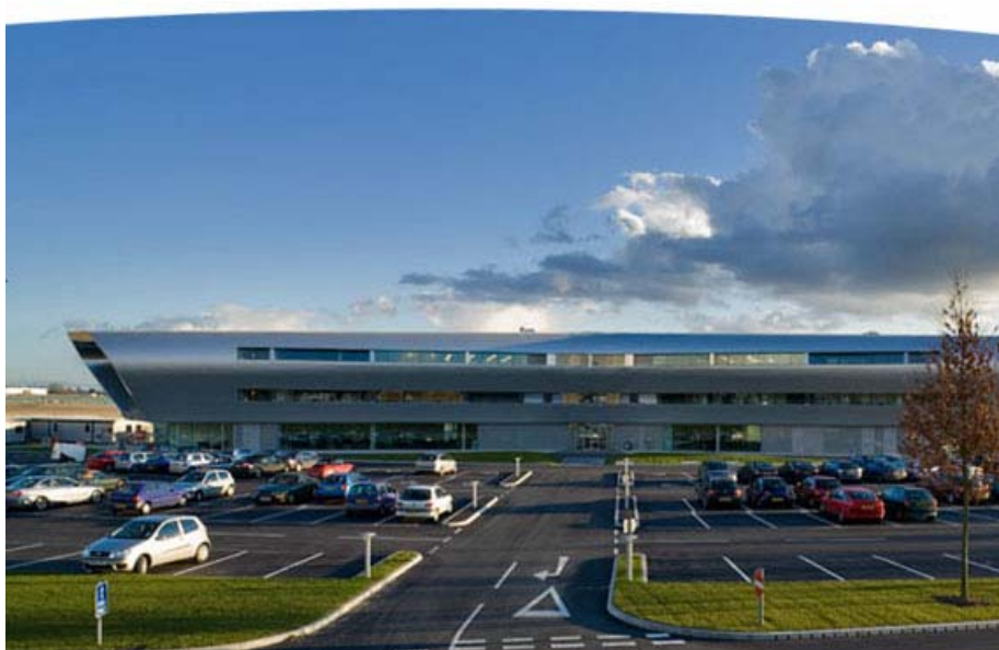
ファンボロー空港ターミナル外観 2
