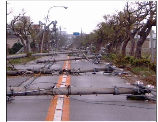
(台風による道路の被災状況)
