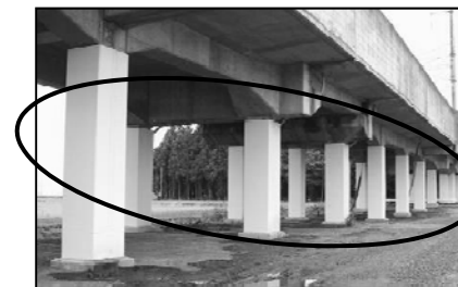
鋼板を巻く耐震補強により倒壊の被害なし
