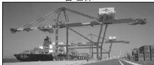
ガントリークレーン
