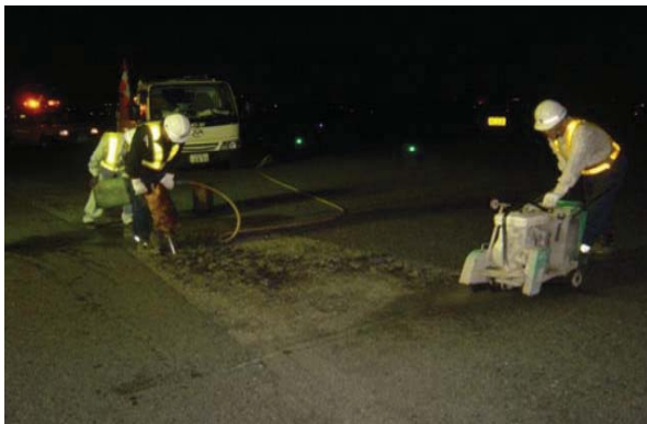
点検を踏まえた補修の実施
