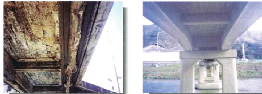
③表面含浸材(けい酸ナトリウム系補修材)
