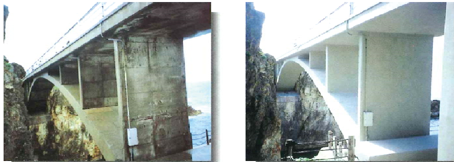
①柔軟形補修材料(ポリマーセメント系補修材)
