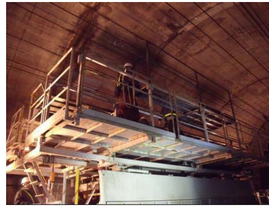
【トンネル天井部の点検の様子】
