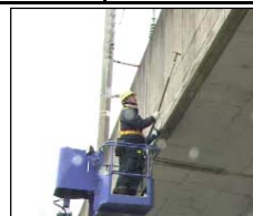
高架橋防音壁の点検の様子
