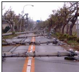
(台風による道路の被災状況)
