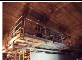
トンネル天井部の点検の様子
