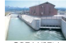
農業用水を活用した小水力発電(従属発電)
