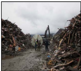
(東日本大震災における道路の啓開状況)
