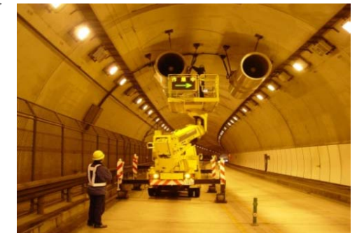
トンネルジェットファンの点検状況
