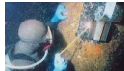
⑤電気防食(水中溶接技術)
