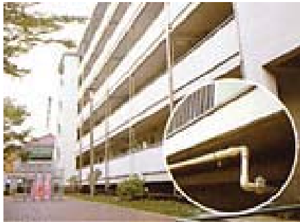
<配管のメンテナンス>
