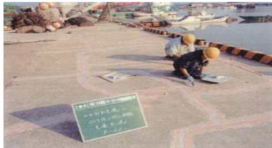
▲ エプロンのひび割れに樹脂を充填
