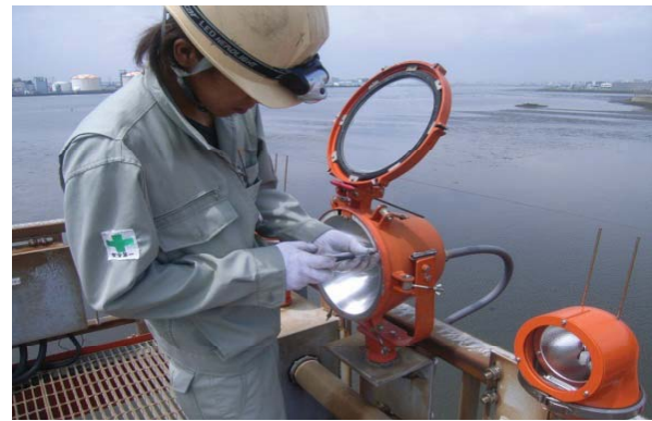
点検を踏まえた補修の実施
