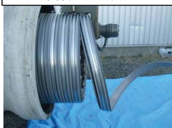
製管工法(例)
