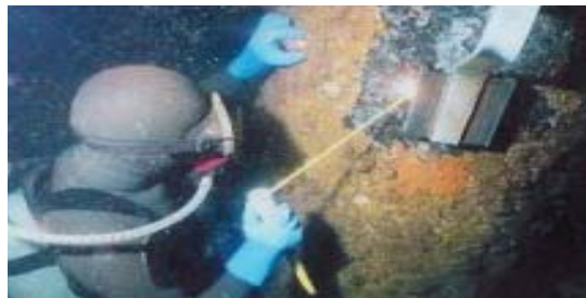
▲ 水中溶接による電気防食の施工
