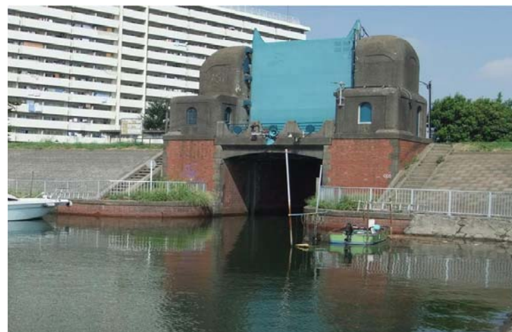
六郷水門(東京都大田区:多摩川) 1930(昭和5)年設置(約82年経過)
