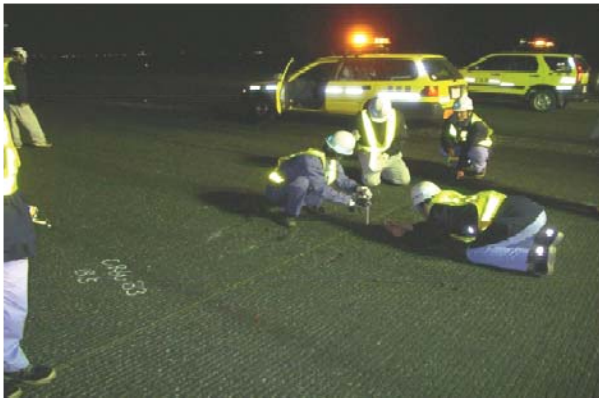
空港基本施設の点検
