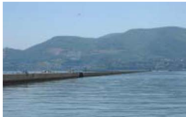
小樽港北防波堤(北海道小樽市) 1908(明治41)年建設(約104年経過)
