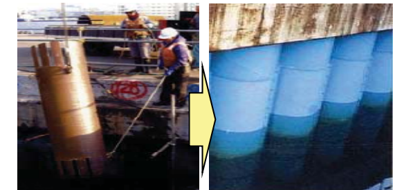
▲ 鋼管杭を鋼板で補強
