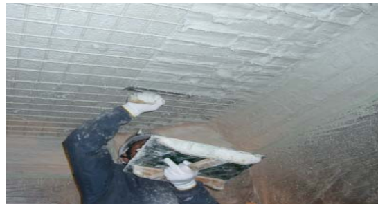
▲ 増厚工法による補強
