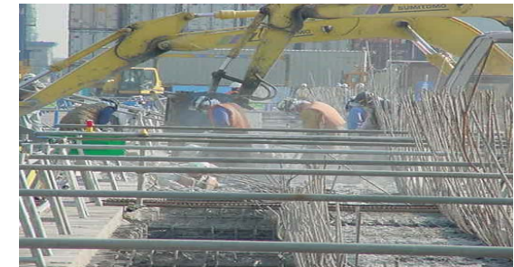
▲ 床版の打ち替え
