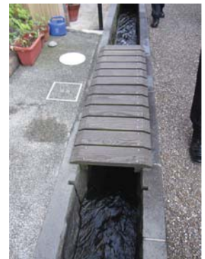
写真 24 水路に架けられた木橋
