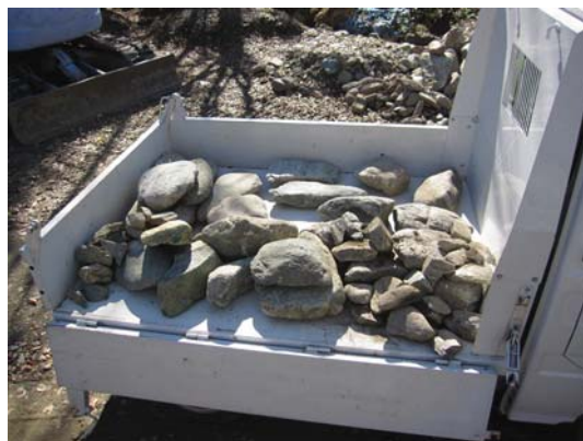
写真 31 補修現場を確認した上で 石積みに使えるような石材を調達
