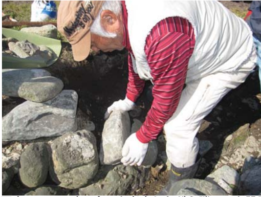
写真36 石の噛み合いを考慮しながら隣の石を設置
