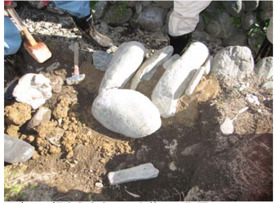
写真37 押さえとなる石を後ろに配置
