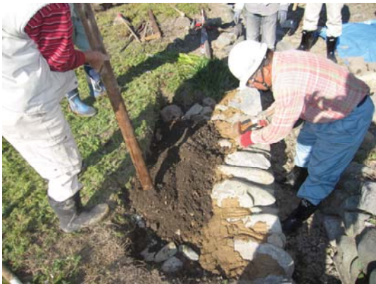
写真40 隙間がでないように粘土を詰めながら 後背部を埋め戻し
