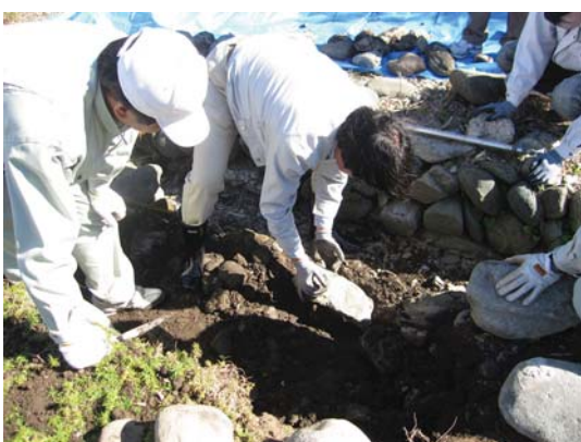
写真 34 基礎石が抜けている部分に 新たに基礎石を設置
