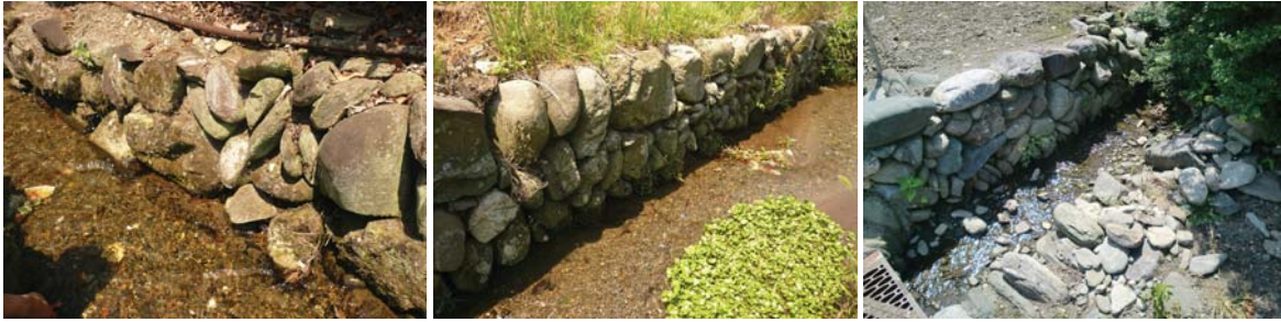
写真 45 区間によって積み方が異なる小堰の石積み
