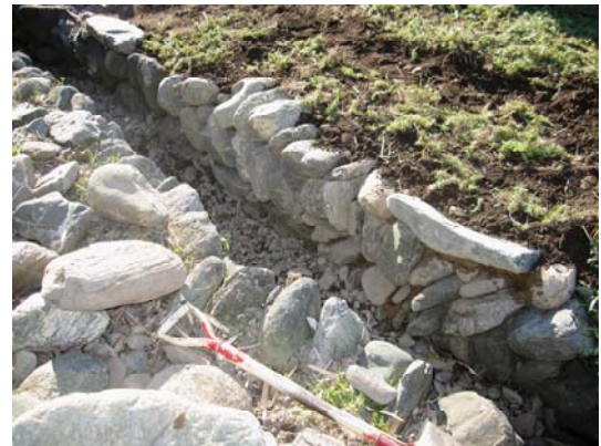
写真41 補修後の状況
