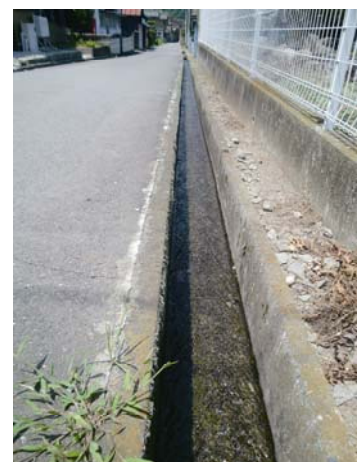
写真5 側溝・コンクリート区間
