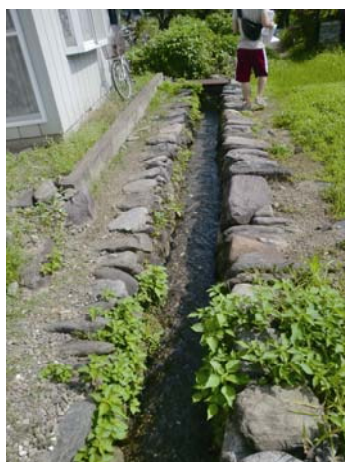
写真3 空石積み区間
