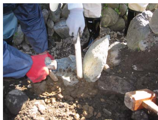
写真 35 銅下げを意識して一段目の石を設置し、 粘土を棒で突いて石と石の隙間を埋める
