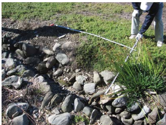
写真 30 補修前の状況
