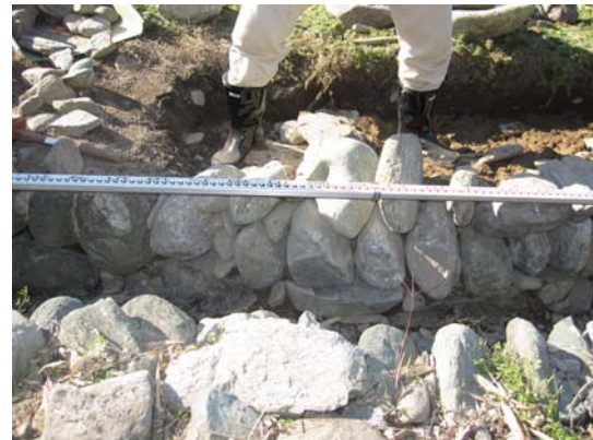
写真39 両サイドの石積みとの天端の高さ関係の確認
