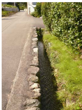
写真4 練石積み区間
