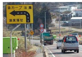
写真2 現道の線形不良箇所
