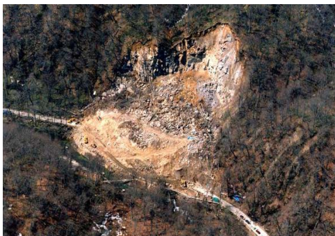
写真1 法面崩壊(H11.3.10)
