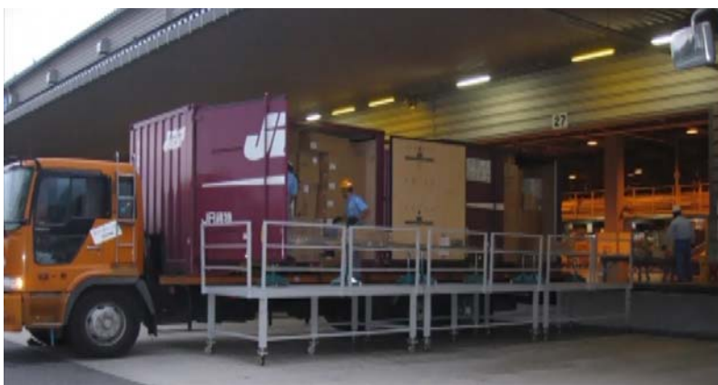
イオン(株)において整備した 12ft コンテナ用荷役設備
