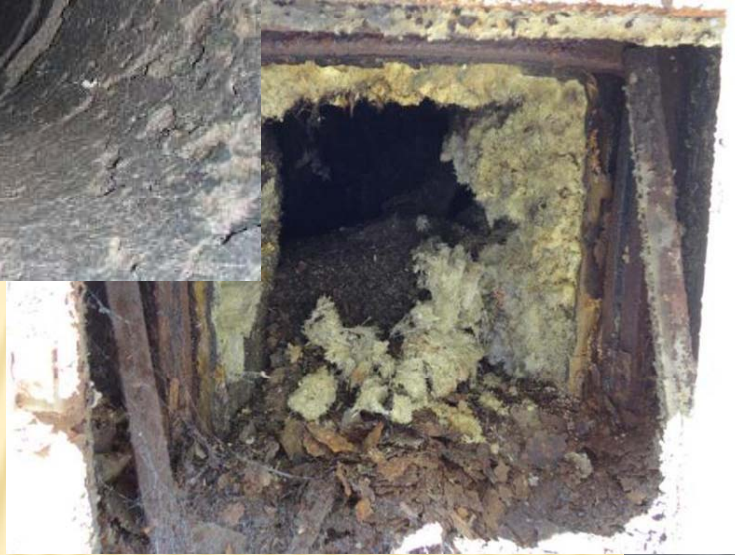
煙突断熱材
