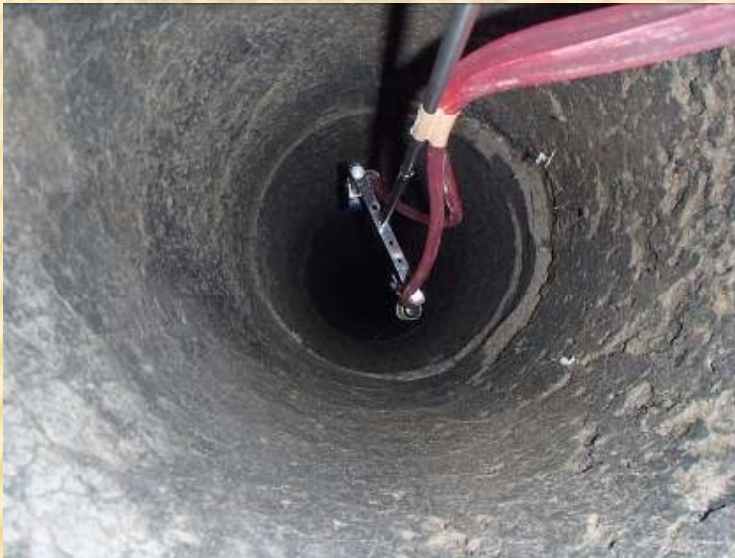
煙突断熱材
