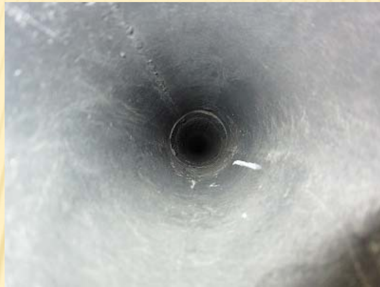
石綿セメント管
