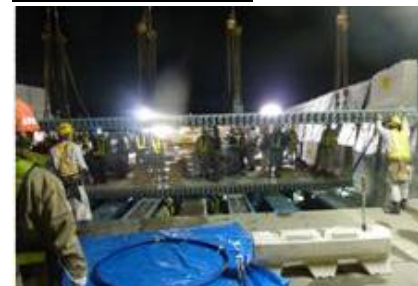
リニューアル (床版取替)
