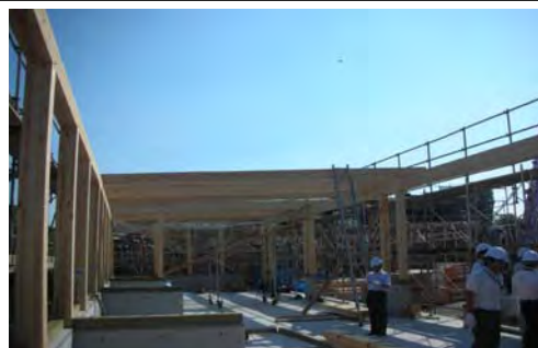
車庫棟：柱・梁の施工状況
