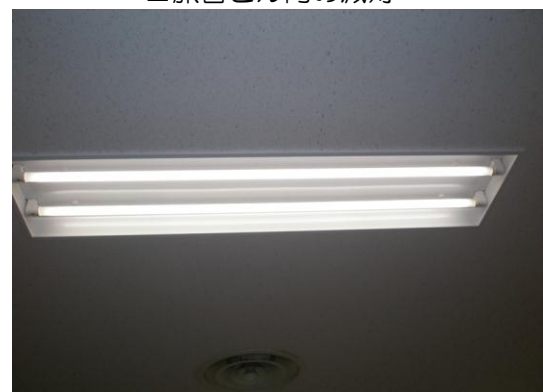
■LED 照明器具の設置
