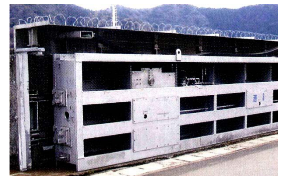
高知県須崎港の事例
