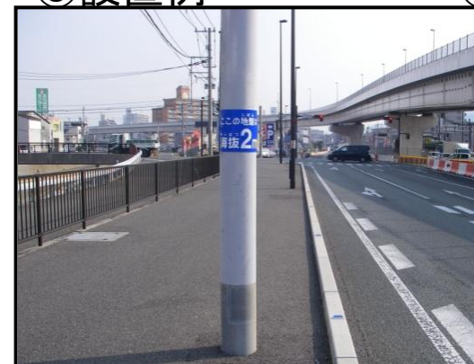
〈国道3号 北九州市 穴生4丁目交差点付近〉
