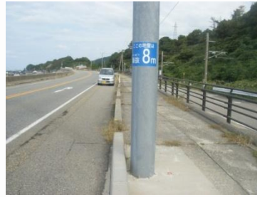
〈国道7号村上市伊呉野地先〉
