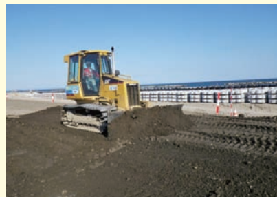
③改良土を敷きならす。その後タイヤローラーで固める。3~4m程度の高さまで盛る。
