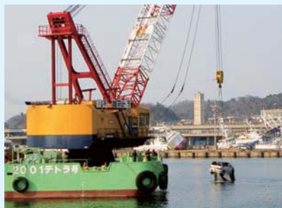
障害物撤去作業
