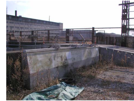
車の利用のある陸閘は廃止し、通行可能なスロープを設置した事例(種崎地区)
