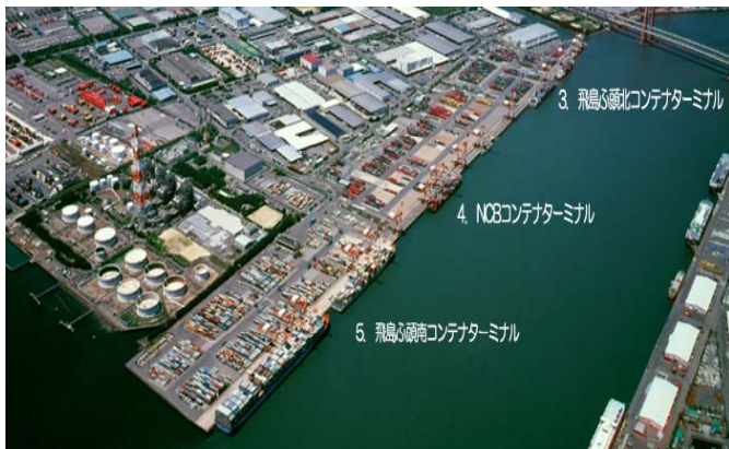
コンテナターミナル (名古屋港:名古屋港管理組合)
