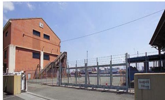
SOLASフェンス (清水港; 中部地方整備局清水港湾事務所)
