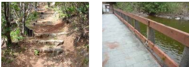
遊歩道の整備
