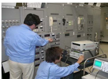
(航空保安施設点検実施状況)
