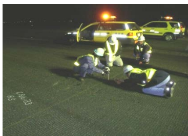
(基本施設点検実施状況)
