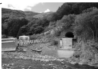
南リアス線荒川橋りょうの被害
