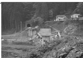
北リアス線島越駅の被害
