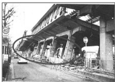
【阪神淡路大震災で倒壊した高架橋】
