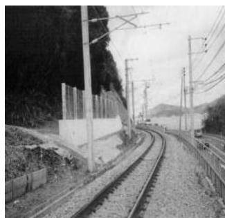
【落石防止擁壁の一例】
