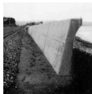
【護岸壁の一例】
