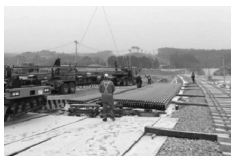
レールの復旧（H24.2.1より敷設開始） （北リアス線：田野畑～陸中野田間）
