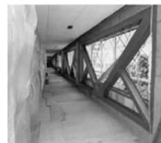
鉄骨ブレースによる壁の補強
