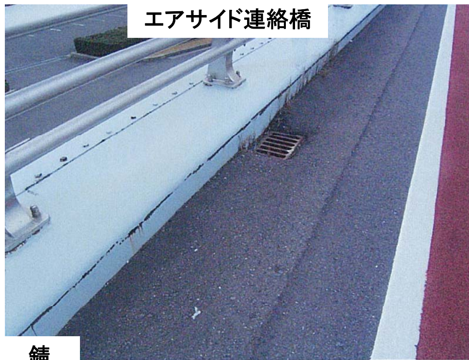
側面のひび割れ
