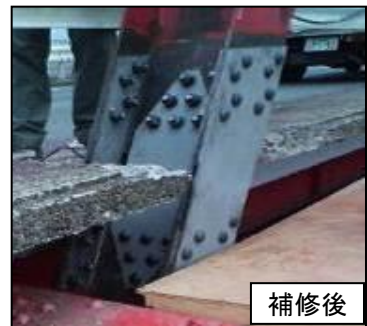
平成19年6月29日補修完了
