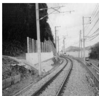
【落石防止擁壁の一例】
