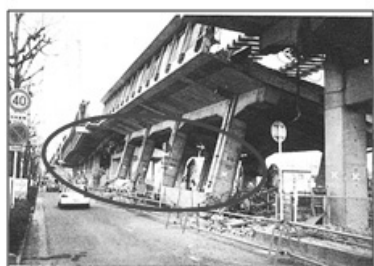
【阪神淡路大震災で倒壊した高架橋】
