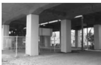
【高架橋の柱に鋼板を巻いた耐震補強】
