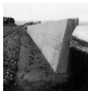
【護岸壁の一例】
