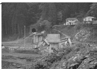
北リアス線島越駅の被害
