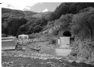
南リアス線荒川橋りょうの被害
