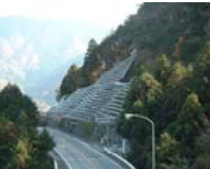
斜面崩落防止対策
