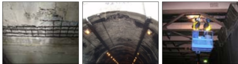
床版コンクリートの剥離 トンネル内のひびわれ発生 橋梁点検状況
