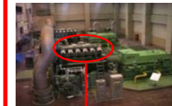
排水機場のポンプ設備の補修
