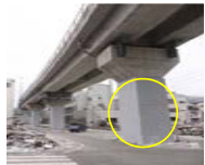
橋脚の耐震補強
