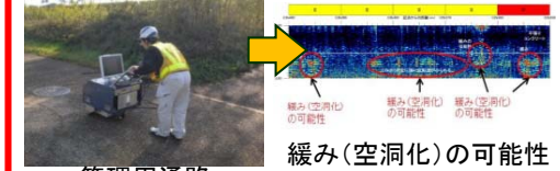
管理用通路空洞化調査
