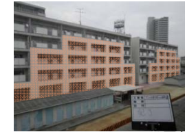
▲外付けフレーム耐震補強
