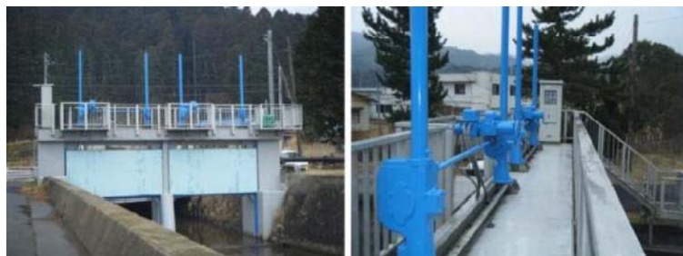
← 【石巻市(旧牡鹿町)後川防潮水門】
