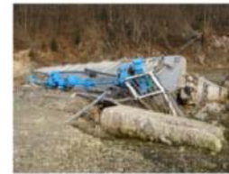
流出した門柱・巻上げ機械設備
