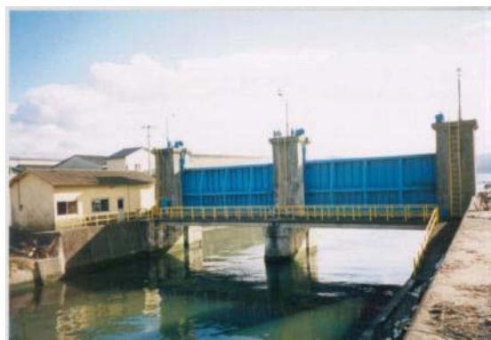
写真: 新井田川防潮水門(被災前)
