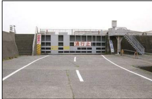
常時閉鎖陸閘(焼津漁港)
