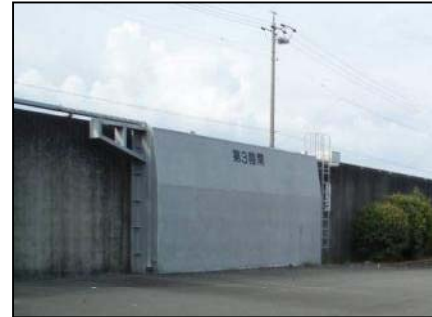
常時閉鎖陸閘(吉田漁港)
