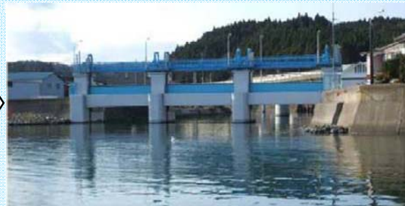
耐震対策・高速化・遠隔操作化実施後
