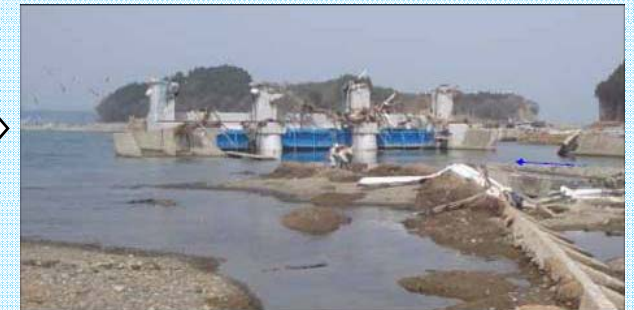
震災直後(水門は閉扉状態)
