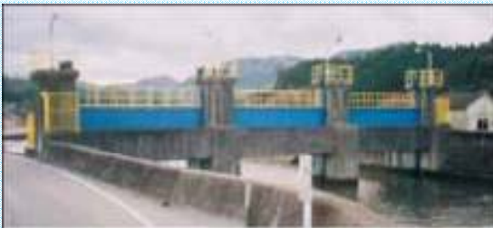
耐震対策・高速化・遠隔操作化実施前
