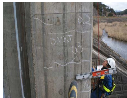
門柱部劣化調査状況
