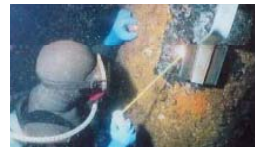
⑤電気防食(水中溶接技術)
