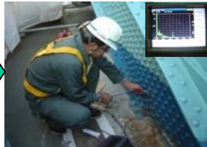
超音波による非破壊検査
