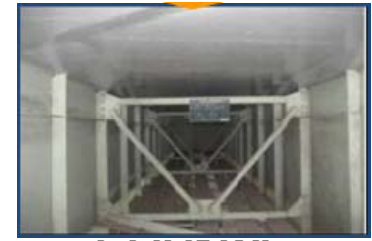
炭素繊維補修
