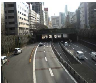
▲走行車線間に橋脚が立つ亀井橋
