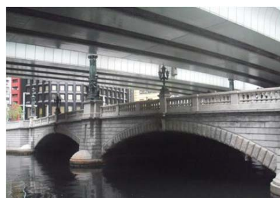
▲上空を首都高速に覆われた日本橋
