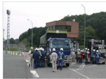
工事場所等のパトロール状況
