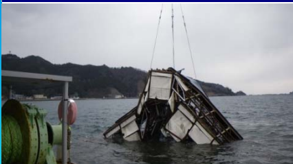
家屋の除去(釜石港)
