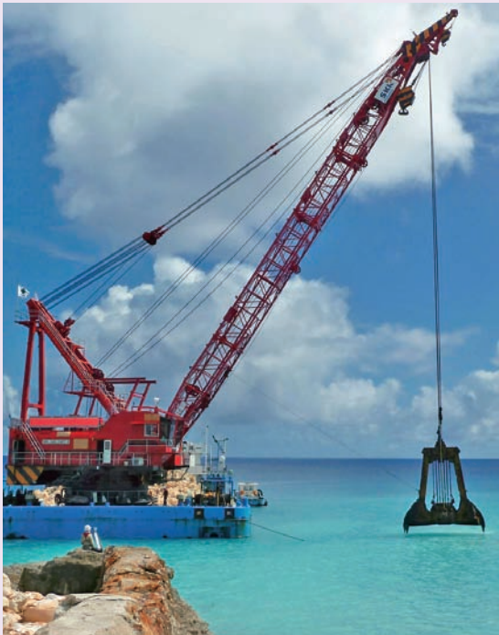
海底の浅い部分を掘る浚渫工事。
