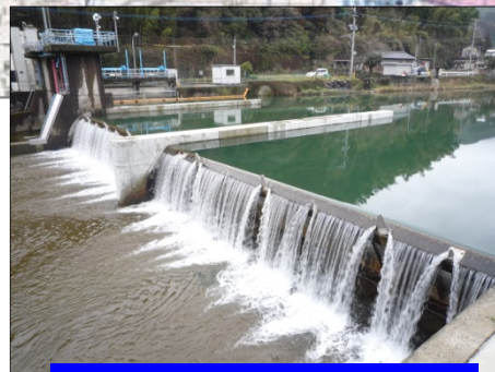
ゲートを改築した女男石頭首工
