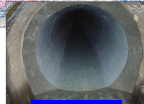
改築した寺内導水路
