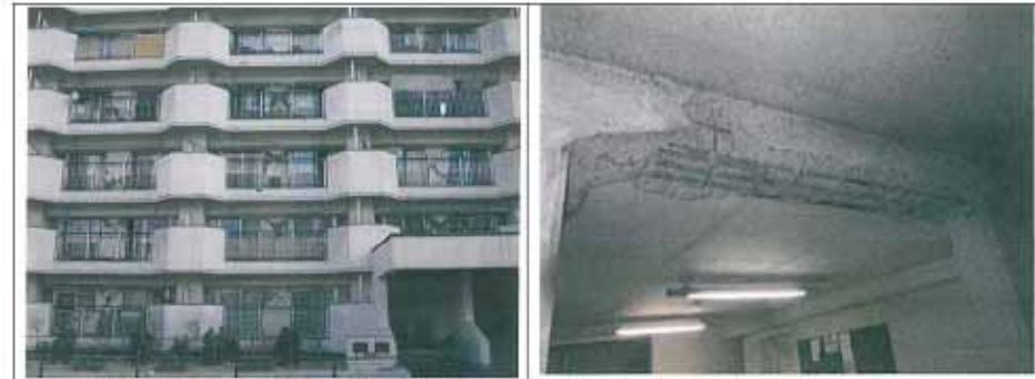
バルコニー側方立壁の損傷
