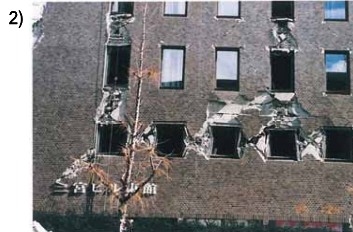
阪神・淡路大震災での揺れによる建物被害の例
