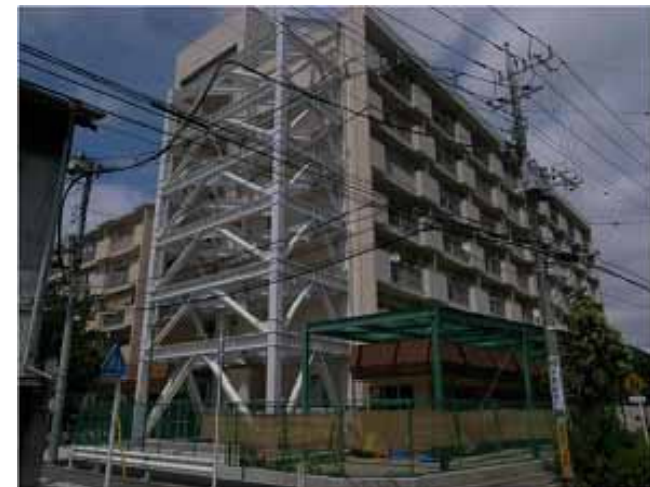
バットレス補強の事例
