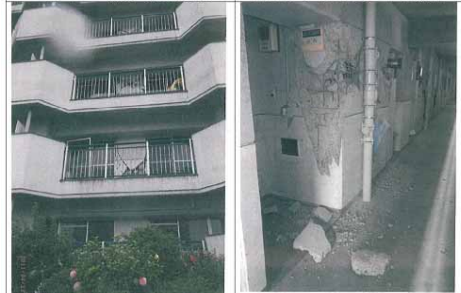
バルコニー側方立壁の損傷
