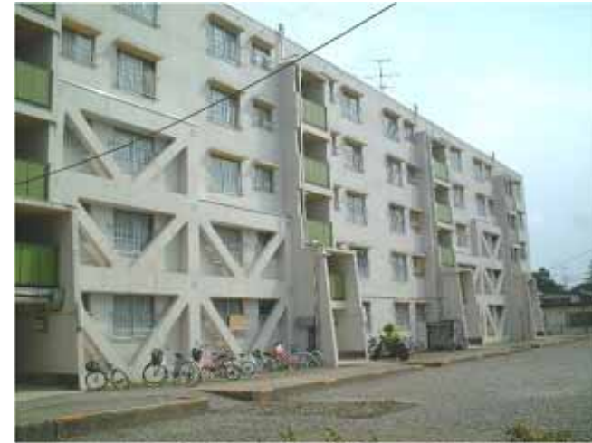
外付けフレーム補強の事例
