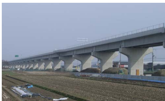
京奈和自動車道一部開通(橿原高田 IC～御所 IC)
