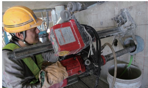
篠原橋の橋脚に落橋防止装置を設置する。既設の鉄筋を切断しないようにコンクリートにドリルで横孔を開け、構造物として一体化させるため鉄筋を挿入。
