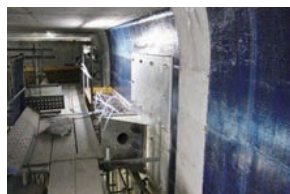
橋桁（図の赤い部分）の内側に設置した炭素繊維シート。
