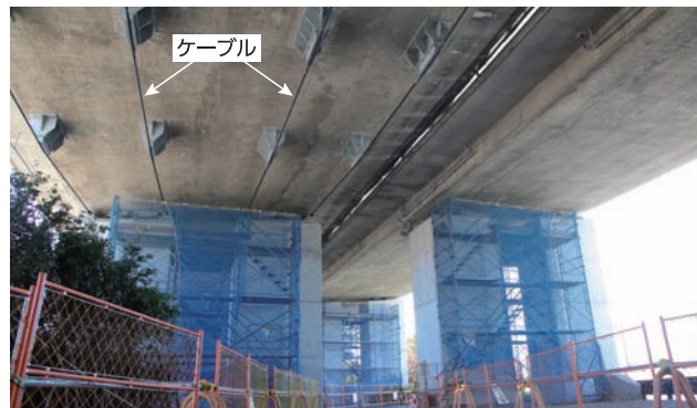
浜名バイパス、篠原橋。床版のひび割れを抑えるためにケーブルを張り、補強を行っている。
