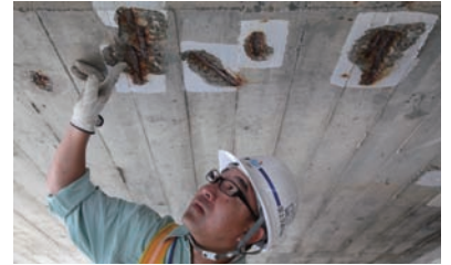
橋桁内部。壁のひび割れ部分に補修用の接着剤を注入。緻密な手作業が必要。
