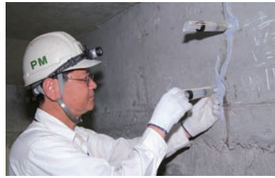
橋桁内部。壁のひび割れ部分に補修用の接着剤を注入。緻密な手作業が必要。
