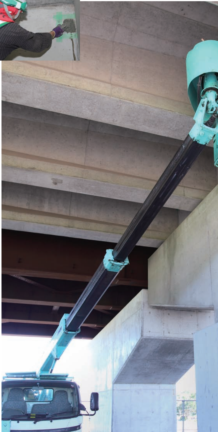
露出した鉄筋周辺のコンクリートをはがし、錆を落とし、防錆（ぼうせい）処理を施した後、コンクリートで修復する。仕上がりの美観にも気を配る。
