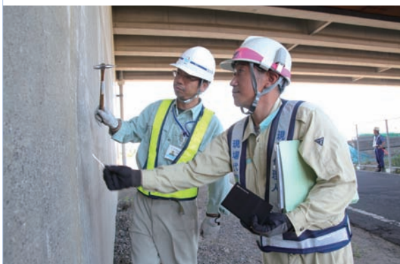
損傷の点検の際は、橋脚の壁面を近接目視した上で、ハンマーで軽く叩く。その音によってコンクリートの浮きなどを確認する。
