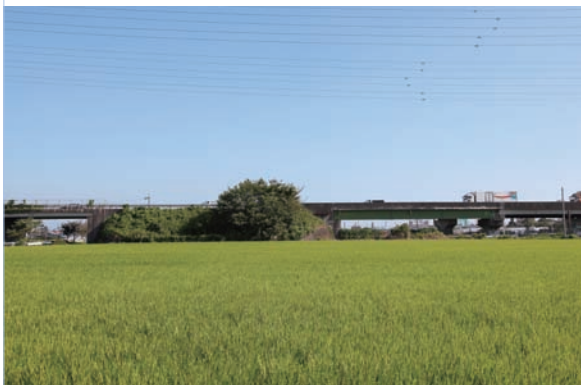
磐田バイパス、加茂川原高架橋は1980年に竣工。30年以上に渡り、地域の人の生活道路となっている。
