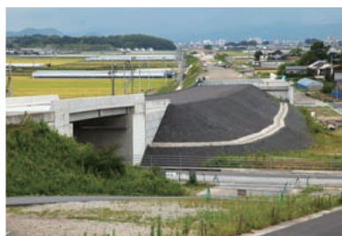
香南市の南国安芸道路(高規格幹線道路)。多重防衛も考慮した盛土方式で建設を進めている。
